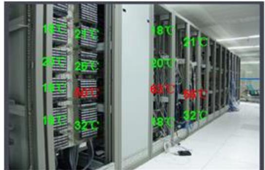
**机柜级微环境监测系统**，可帮助合理设置空调温度、风速，调整出风口方向。如果选装机柜自动通风系统更可以提高制冷利用率，降低能耗。
